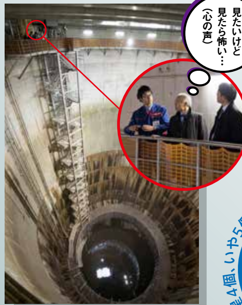
洪水時に水を取り込む5つの立坑のうち、第1立坑を特別な許可を得て見学。深さ72メートルの巨大な立坑は恐る恐る覗き込むのがやっと。 ※通常の見学コースでは見られません。
