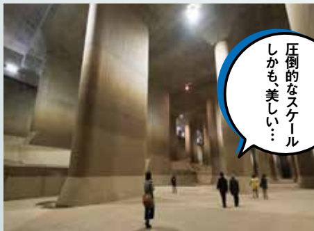
13年の歳月をかけ、つくられた首都圏外郭放水路。そのほんの一部である調圧水槽。あまりの巨大さは圧巻です！
