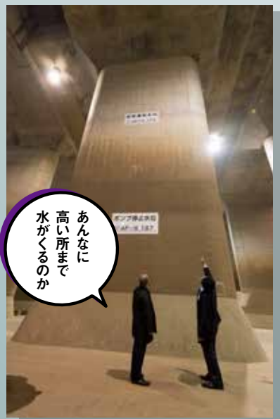
長さ177メートル、幅78メートル、高さ18メートルの調圧水槽。水が流入した痕跡が、そこかしこに。
