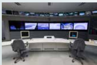
情報が集まり、放水路全体をコントロールする操作室。
